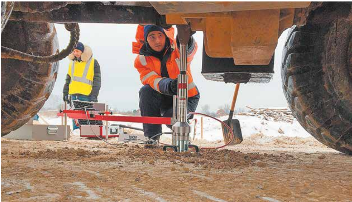
На полигоне осуществляется послойная оценка качества дорожного покрытия с применением передвижной установки динамического нагружения
