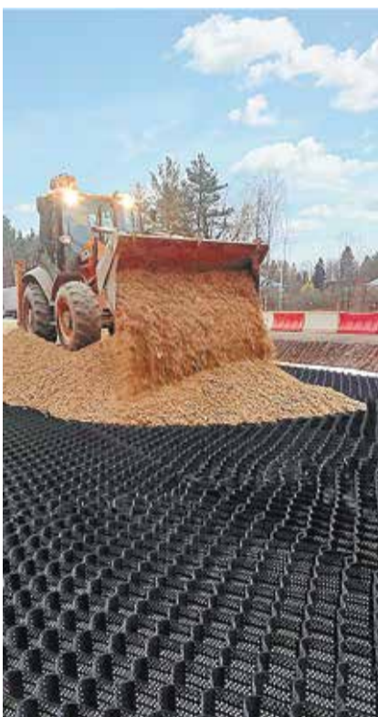
Засыпка георешетки, армирующей слою «дорожной одежды»
